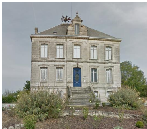
Ancienne mairie, Google Street View
